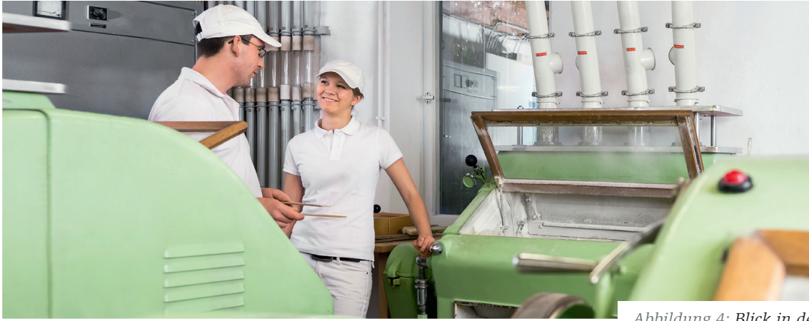
Abbildung 4: Blick in den Walzenboden der Mühle
